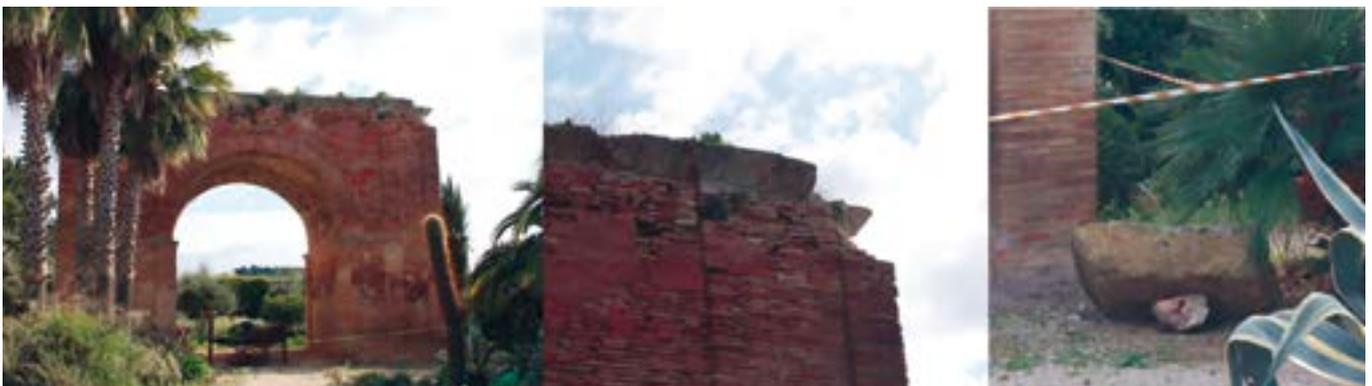
Arco onorario deteriorato dal cedimento di parte del cornicione, con particolari della parte danneggiata e del masso a terra. (Foto Specchio, gennaio 2022)
